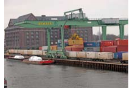
Solange das neue Ausziehgleis für die BEHALA nicht fertiggestellt ist, heißt es rangieren und Züge teilen, ehe in den Westhafen eingefahren werden kann. (Bild: BEHALA)
