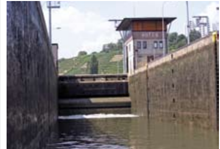
Die Neckarschleuse in Hofen wenige Kilometer vor Stuttgart wurde zwischen 1955 und 1957 erbaut. (Bild: Plochingen Neckarhäfen GmbH)
