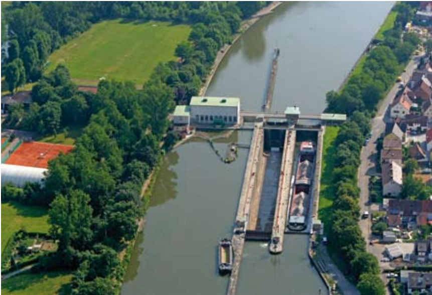
Neckarschleuse bei Horkheim. Die linke Kammer wurde zwischen 1948 und 1951 erbaut, die rechte Kammer 1959 bis 1960. (Bild: Plochingen Neckarhäfen GmbH)
