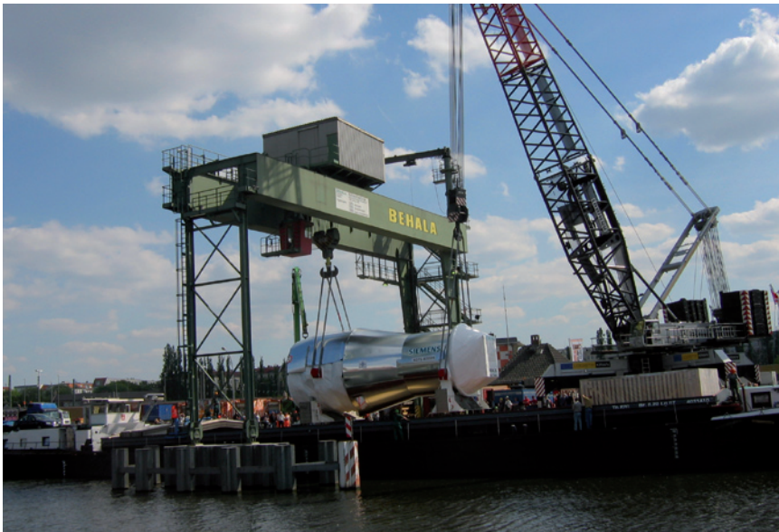
In mehreren Teilen wurde die rund 500 Tonnen schwere Gasturbine mit Binnenschiffen in den Berliner Westhafen transportiert. (Bild: BEHALA)
